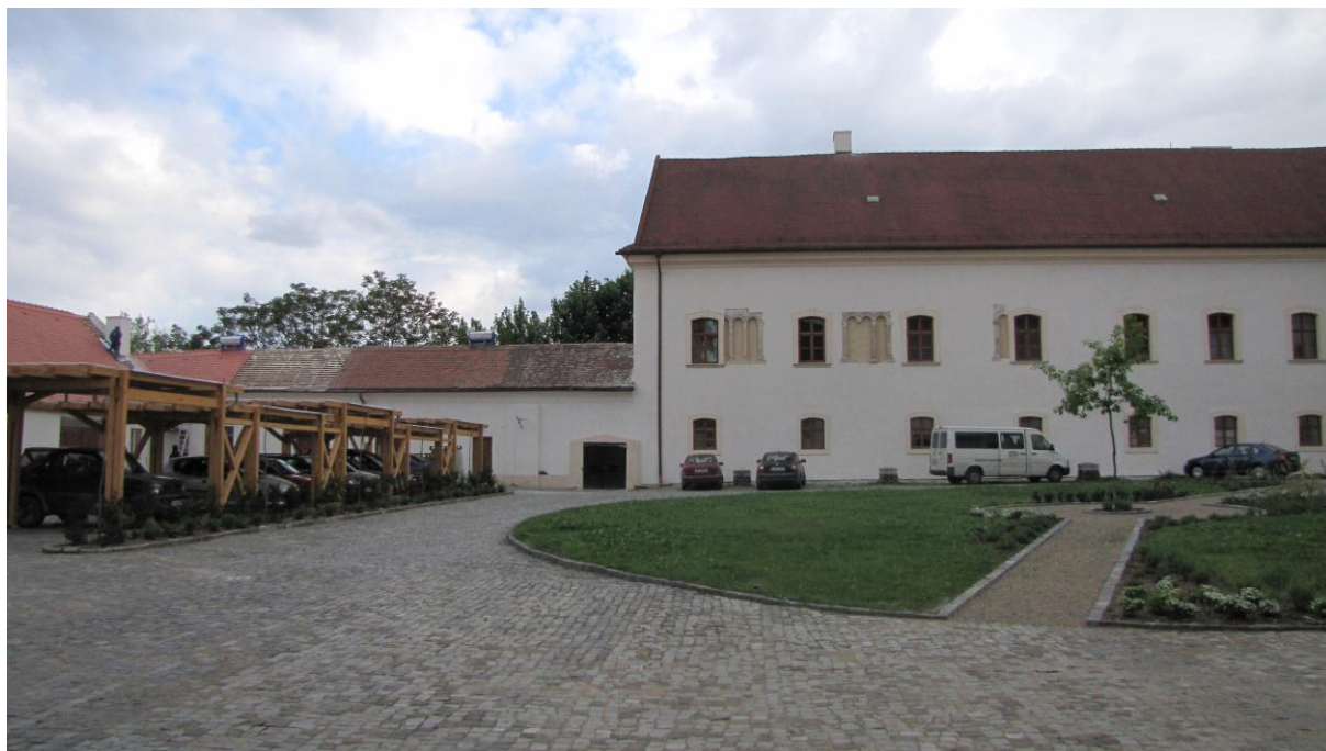
A palota belső udvara (déli épületszárny, balra lefedett fa szerkezetű kocsibeálló)
