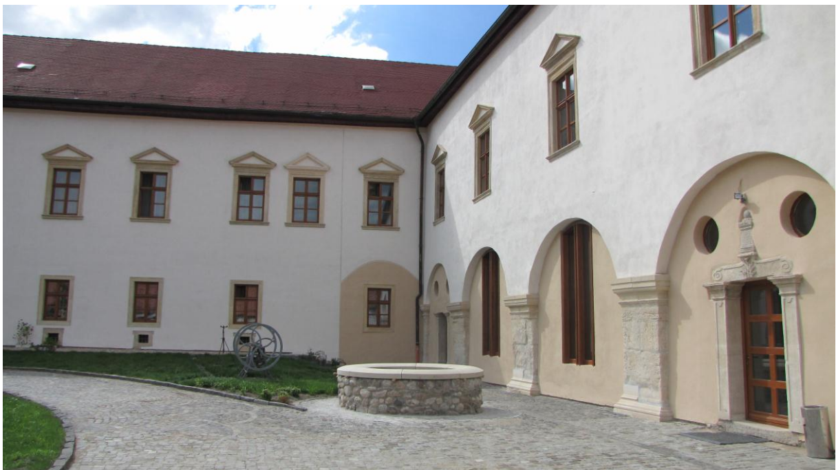
A palota belső udvara a felújított kúttal (nyugati és északi épületszárny)
